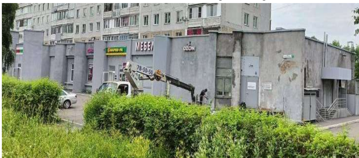
Процесс покраски фасада ООО «Отель Бардин» ул.Косыгина, 7
